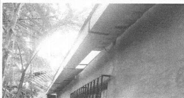
Foto 3: INSTALACION DE BAJADA DE AGUA PLUVIAL DE METAL
