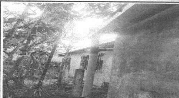
Foto 1: MODULO 2. INSTALACION DE BAJADA DE AGUA PLUVIAL EN LA PARTE DE ATRÁS DE LAS AULAS
