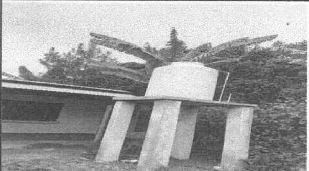
Foto 4: MODULO 3. BASE PARA TINACO
