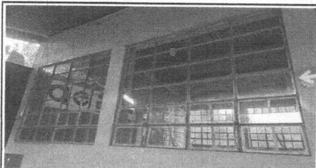
Foto 3: MODULO 1. MANTENIMIENTO DE VENTANALES E INSTALACION DE VIDRIOS.
