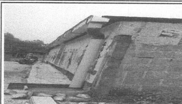
Foto 2 MODULO 1. INSTALACION DE BAJADA DE AGUA PLUVIAL ENFRENTA DE LA ESCUELA
