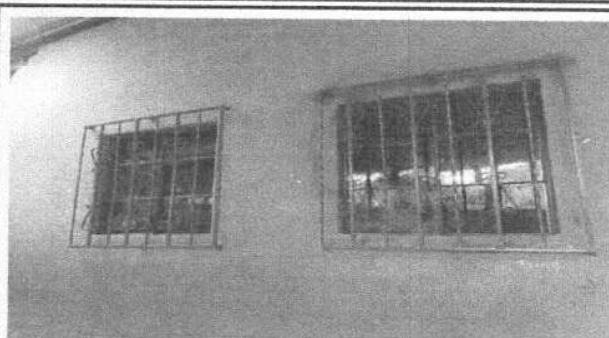
Foto 2: MODULO 1 REPARACION Y MANTENIMIENTO DE BALCONES
