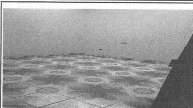
Foto 2: MODULO 1. INSTALACION DE PISO CERAMICO AULA ENFRETE DE SEXTO GRADO.
